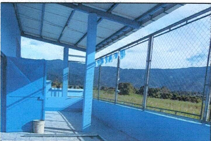
Foto 3: COLOCACIÓN DE MALLA
