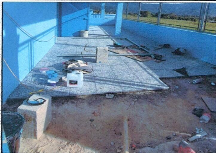
Foto 1: COLOCACIÓN DE PISO EN CORREDOR
