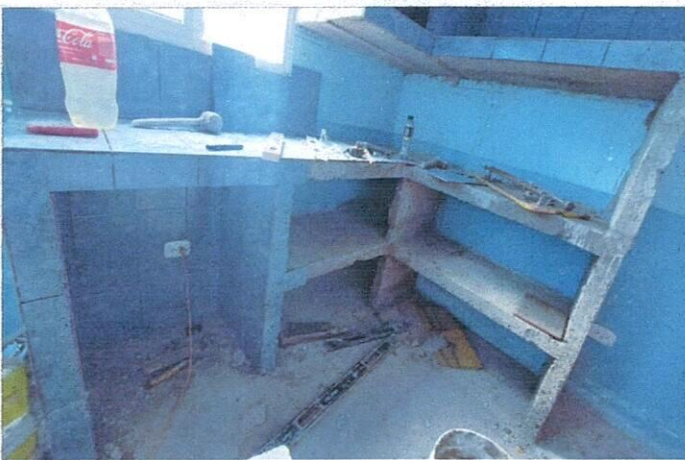
Foto 3: MANTENIMIENTO DE COCINA
