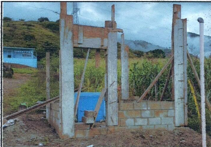
Foto 1: REPARACIÓN DE CISTERNA Y DEPÓSITOS DE AGUA
